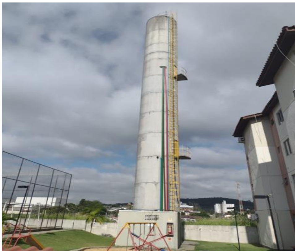
Figura 5: Torre dos reservatórios.
