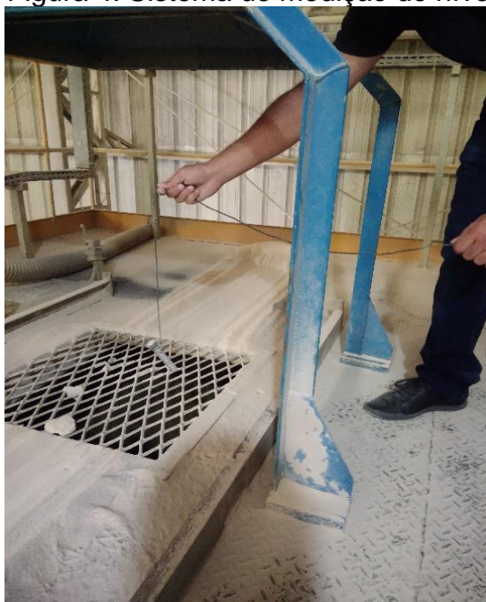
Figura 4: Sistema de medição de nível na cerâmica atual
