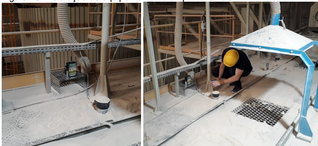
Figura 18: Instalação do equipamento na empresa CEUSA.
