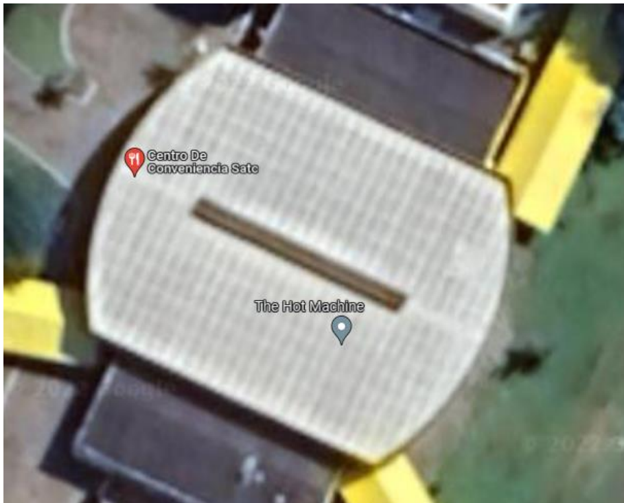
Figura 7: Local da Instalação dos Painéis Solares.
