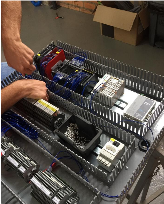
Figura 7: Montagem do painel elétrico.
