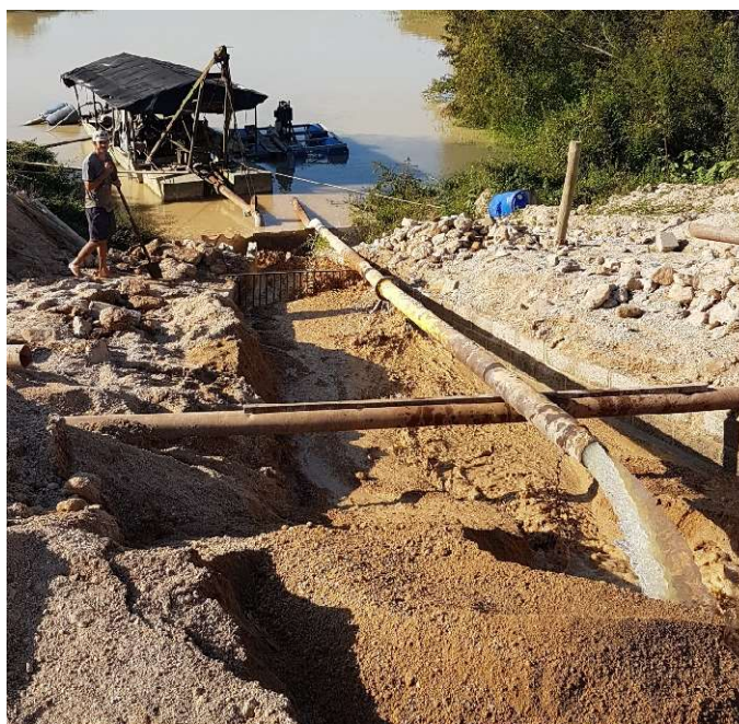
Figura 15 – Lavagem do minério bruto, sendo conduzido para a lagoa (separação de finos) e posterior sucção por draga.
