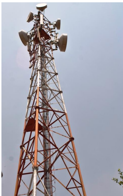
Figura 1 – Torre de telecomunicação (Entelco Telecom, 2013).
