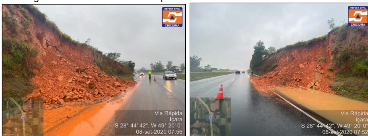
Figura 10: Movimento de massa em função do excesso de chuva, proporcionando o escorregamento no km 04 da Via Rápida.
