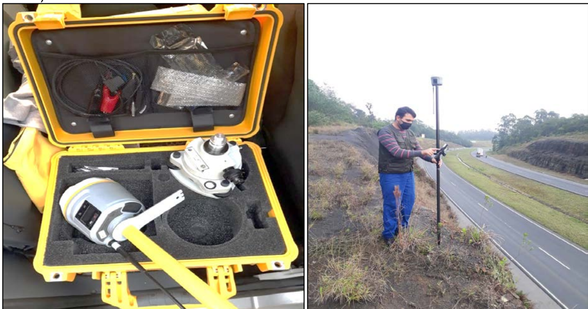
Figura 4: Modelo de Receptor GPS Geodésico utilizado (à esquerda) e coleta de pontos com GPS RTK sendo executado no talude rodoviário do km 06 da SC-446 (à direita).
