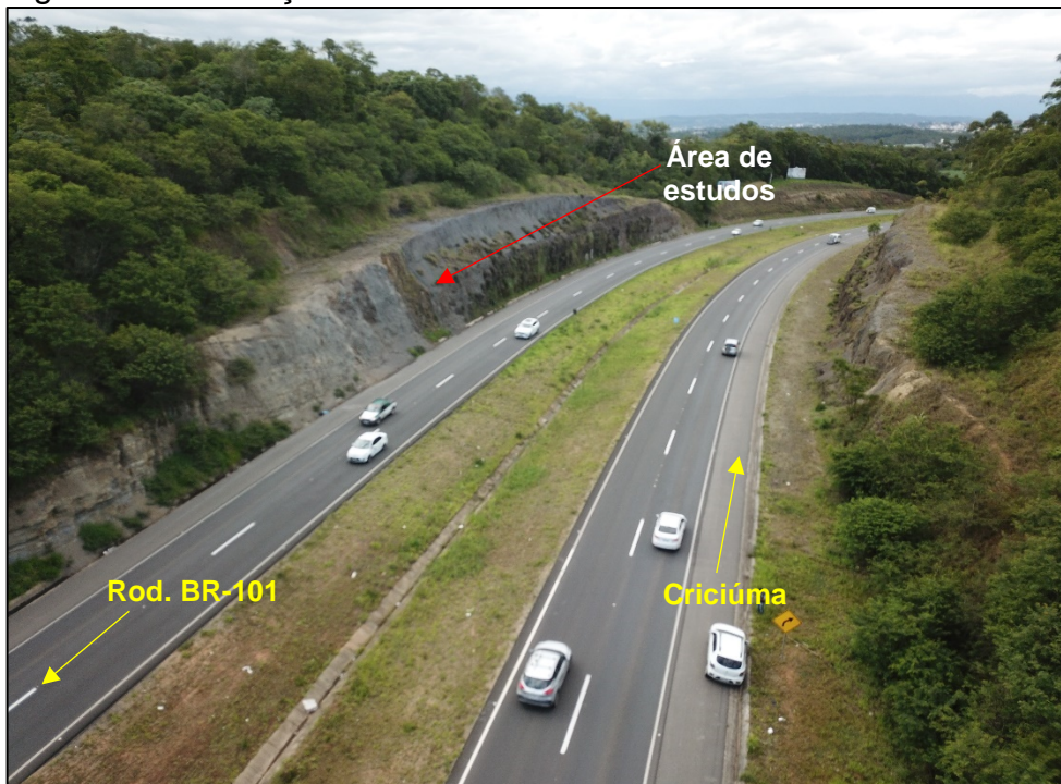
Figura 8: Localização do talude rodoviário no Km 06 da SC-446.
