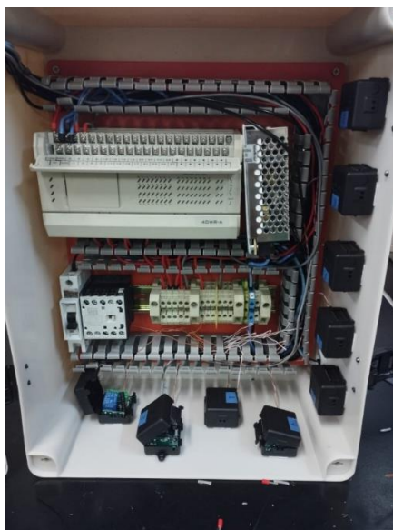
Figura 16 – Processo de instalação dos fios.
