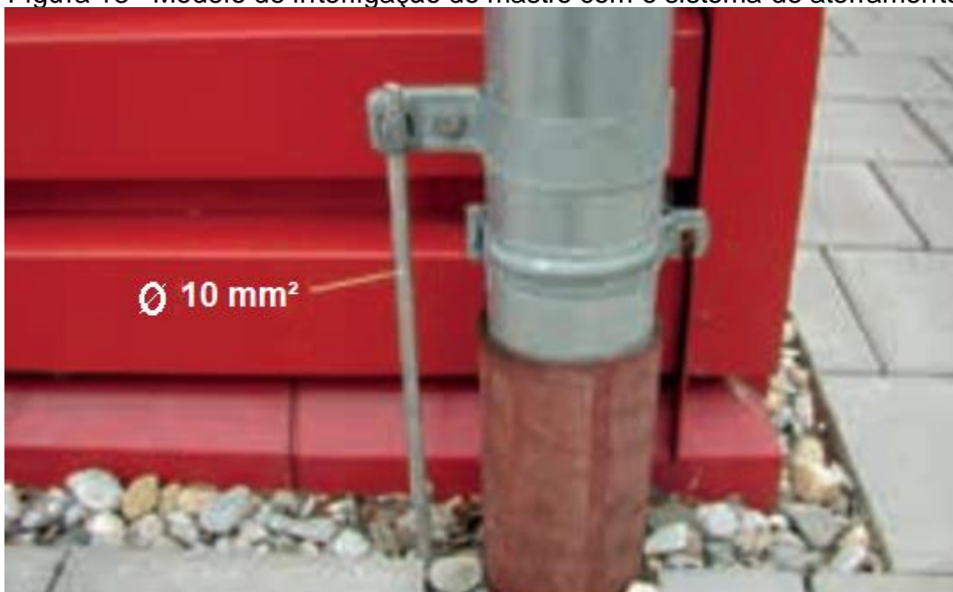
Figura 13 - Modelo de interligação do mastro com o sistema de aterramento.
