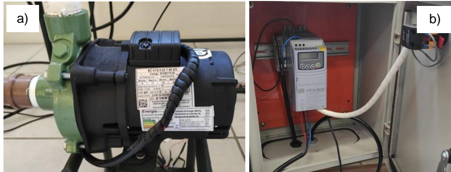
Figura 6: Componentes utilizados para alimentação do sistema de água. a) Bomba hidráulica modelo BC-91 S. b) Inversor de frequência modelo CFW300.
