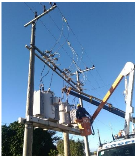
Figura 20 - Regulador de tensão sendo instalado na rede da empresa Coopera, após retirada para manutenção
