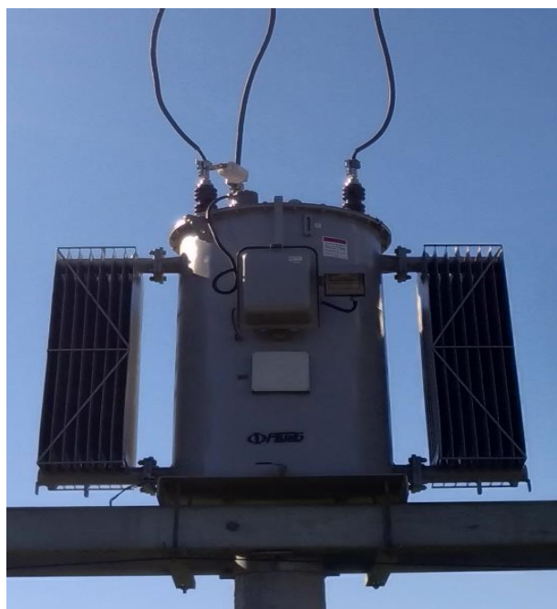
Figura 15 - Regulador de tensão monofásico TOSHIBA, durante manutenção na empresa Fluxo transformadores
