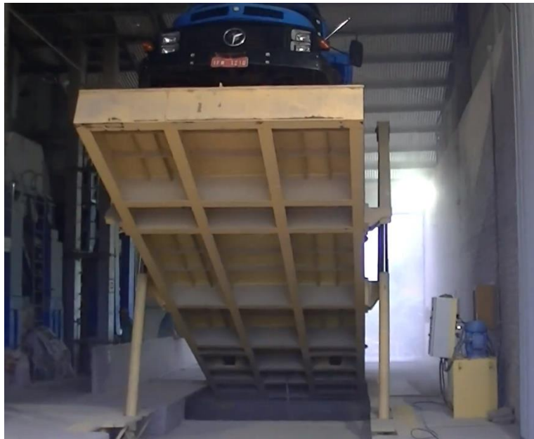
Figura 1: Tombador em funcionamento
