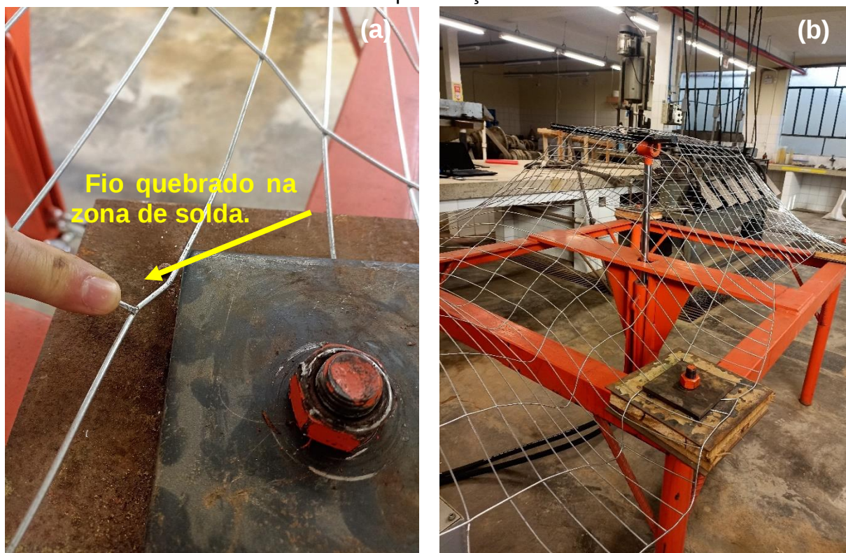
Figura 18: (a) Ruptura na tela eletrosoldada galvanizada, (b) Tela em contato com chapa de aço.
